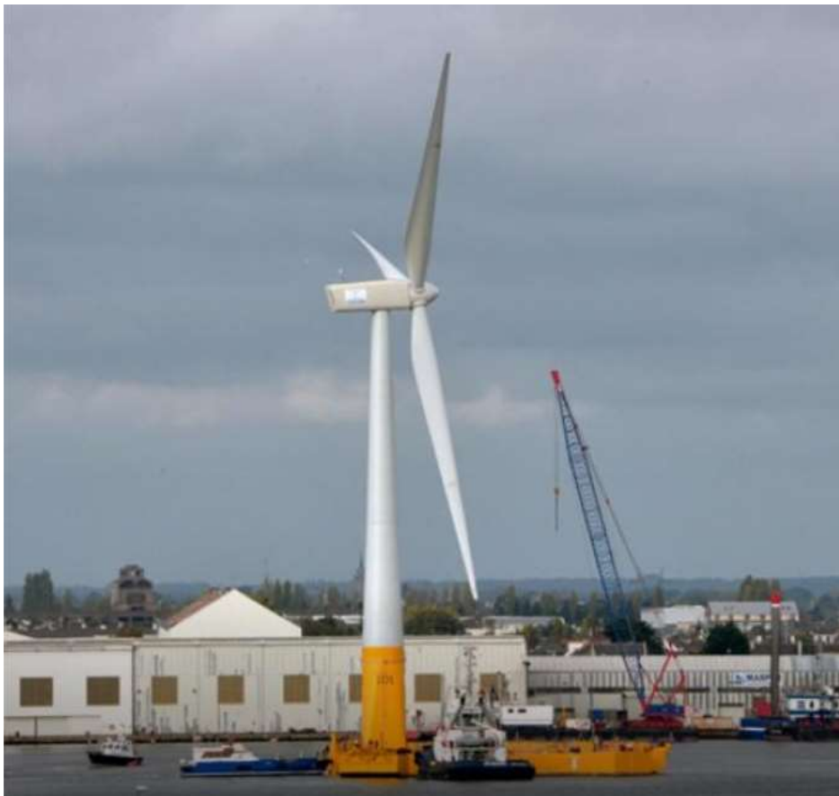
Photographie de l'éolienne FLOATGEN à quai dans le port de Saint-Nazaire
