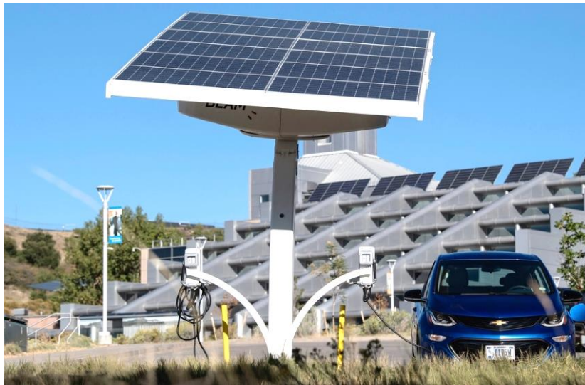
une station solaire de recharge pour voitures électriques – Crédit photo : licence CC0 (domaine public)
